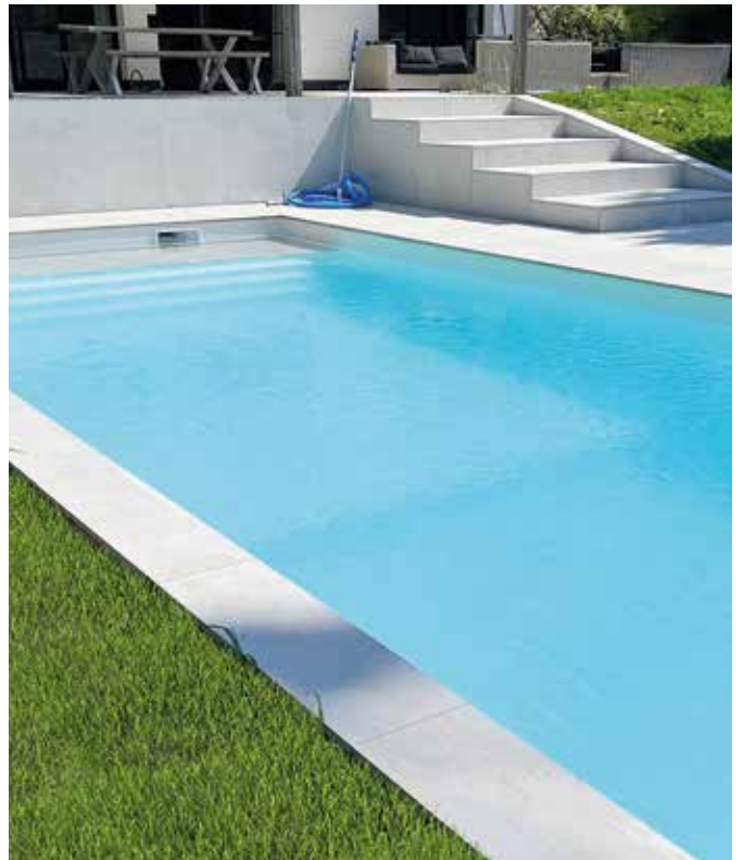
S20 / PISCINES HYDROSUD VALENCIENNES
