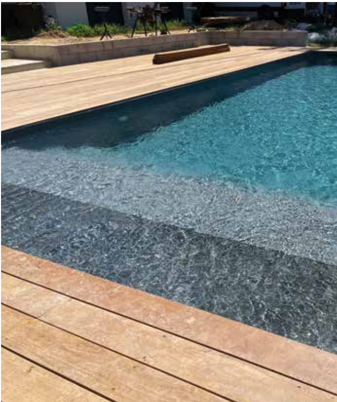
EAU & TECHNIQUE 82 / PISCINES HYDROSUD MONTAUBAN
